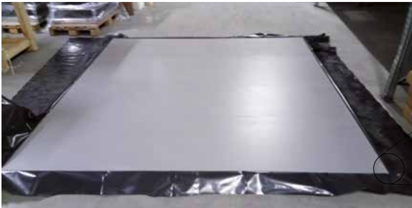
Bodenplatten mit Feder und Nutsystem einlegen
