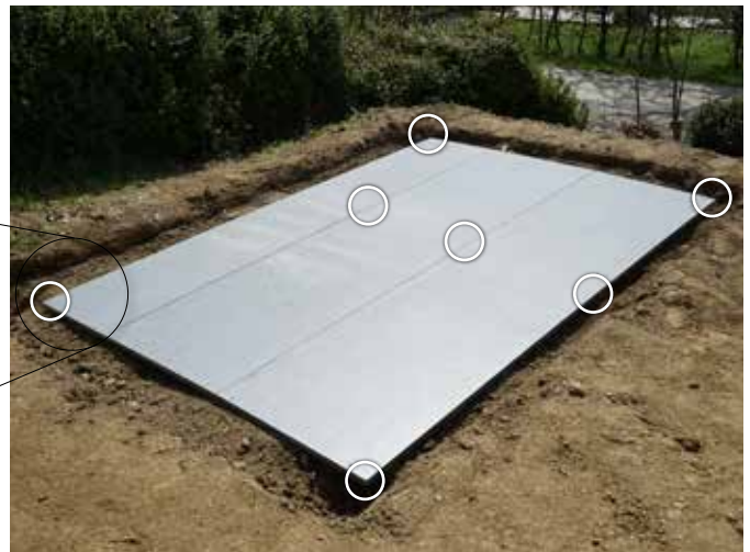
Bohrpositionen markieren
