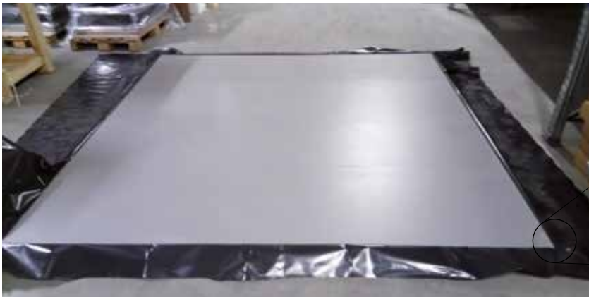
Bodenplatten mit Feder und Nutsystem einlegen
