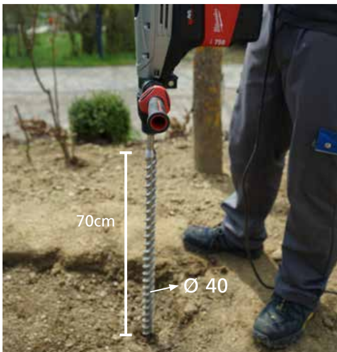
Mit einem 40mm Bohrer mindestens 550mm vorbohren
