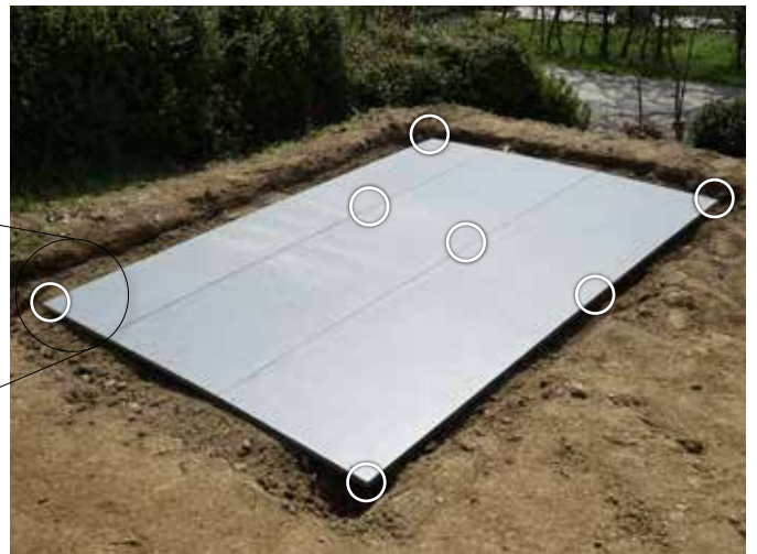
Bohrpositionen markieren
