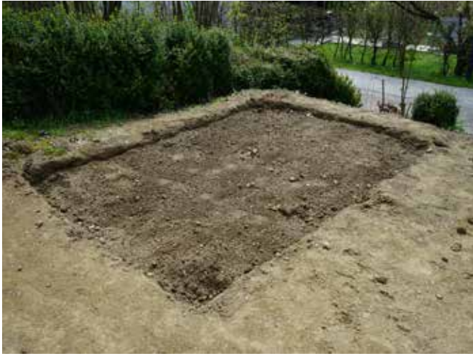
Grundfläche des Hauses ca. 10cm ausheben
