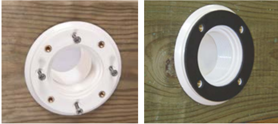
Abbildung 24 – Montage der Ausstoßdüse und seiner Dichtung
