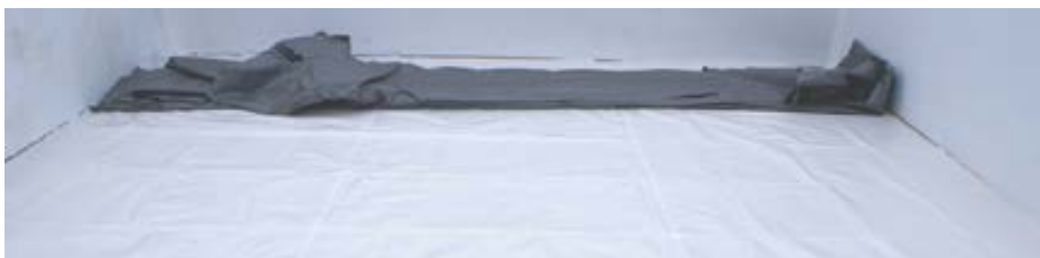
Abbildung 33 – Entfalten der Folienauskleidung
